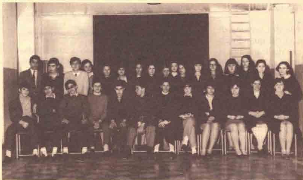
La 1 a C del 1967-68 in via Cagnola prima del trasferimento in viale Marche
